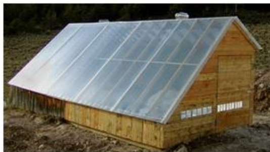
FOTO 7: Galpão de secagem solar- Pascalite
